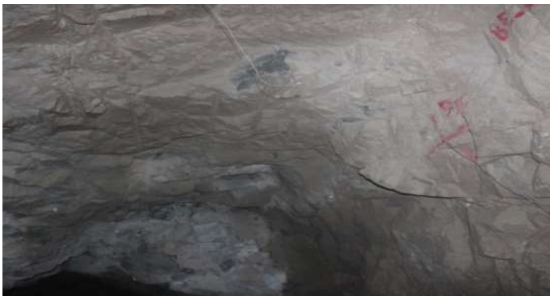
4.15 Сурет – Тәжірибелік жарылыстың нәтижелері-контурлық жаруды қолдану кезіндегі қазбаның төбесі
