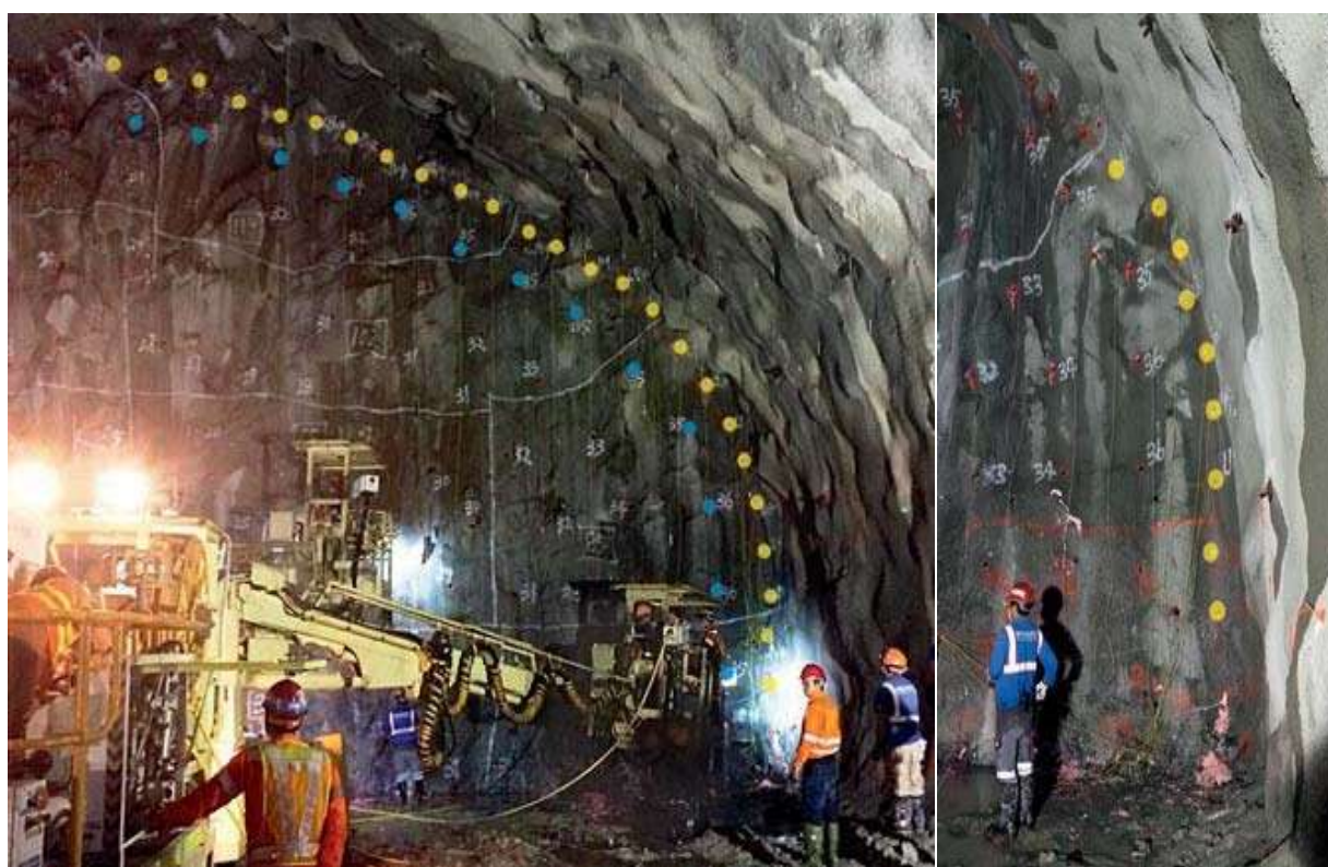
2.3 Сурет – Бірінші жарылыс (MVC-024), ұзындығы бойынша шашыраңқы зарядпен зарядталған 0,6 кг/п. м.; төртінші жарылыс (MVC 027) периметрдің оң жақтағы бөлігі тиісінше String Loading технологиясы бойынша 0,6 кг/п. м. және 1,2 кг/п. м. ЭВВ-мен зарядталған.
