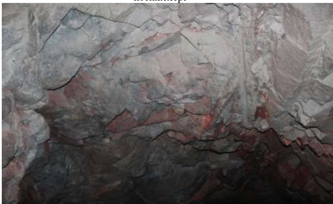
4.14 Сурет – Тәжірибелік жарылыстың нәтижелері-кәдімгі жарылыс кезіндегі қазбаның төбесі
